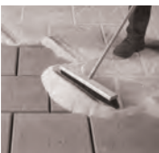
Jointoiement au sable polymère recommandé
