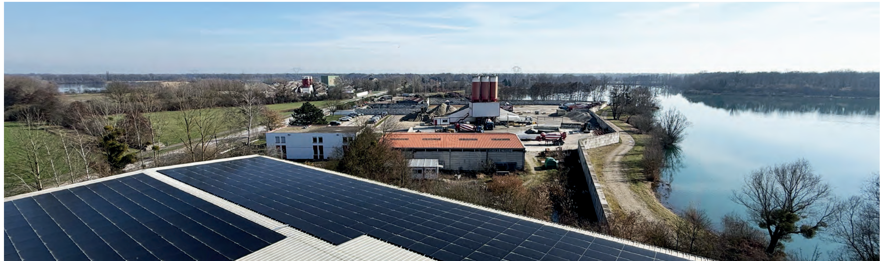
Panneaux photovoltaïques à Krautergersheim
