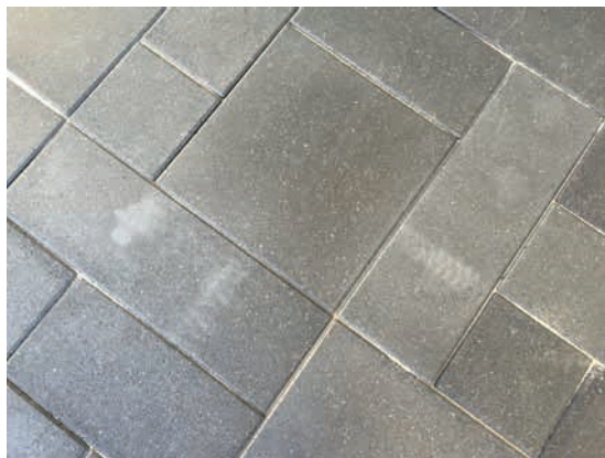
Entstehung von Ausblühungen auf Betonpflaster
