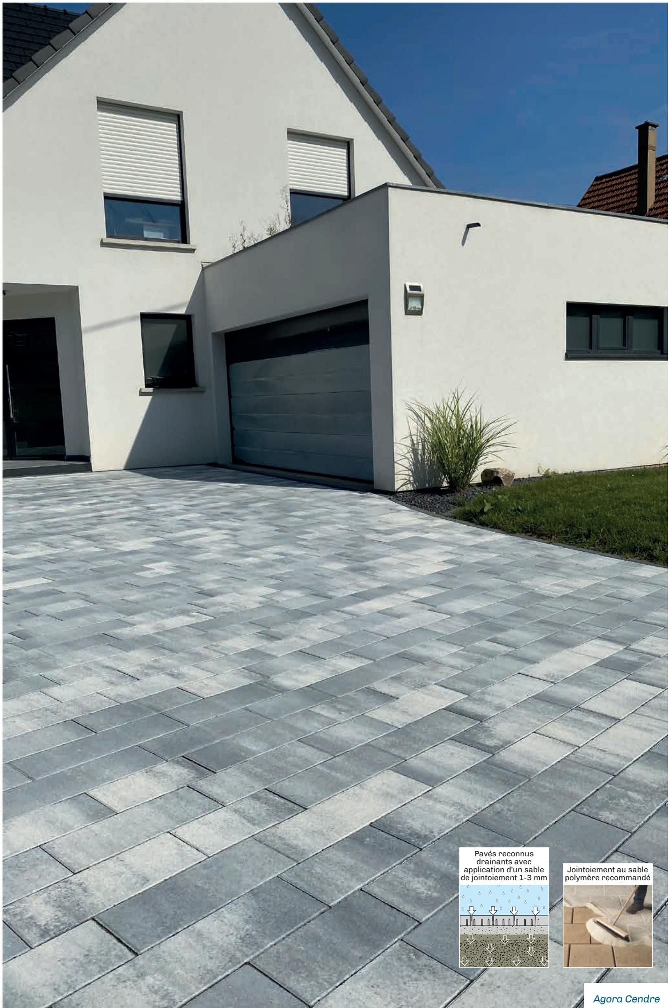
Pavés reconnus drainants avec application d'un sable de jointoiement 1-3 mm
