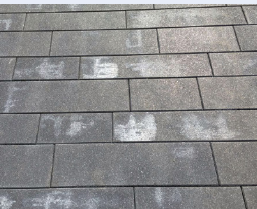
Principe de formation des efflorescences sur un pavé en béton
