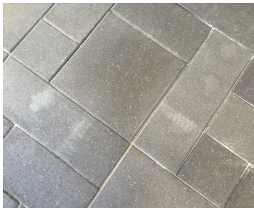
Entstehung von Ausblühungen auf Betonpflaster
