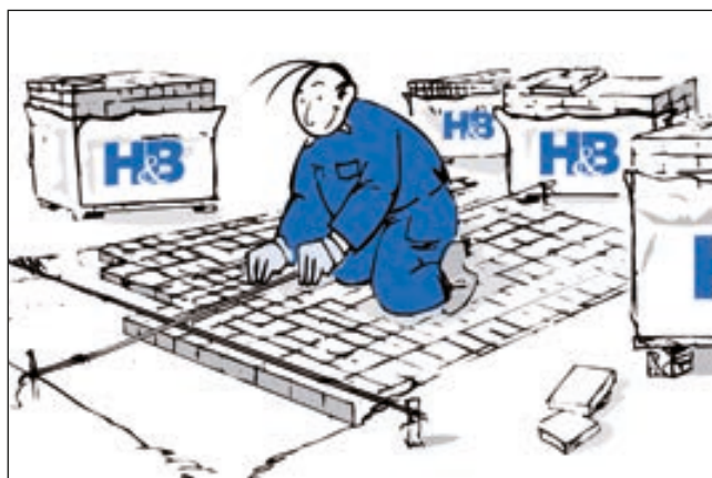
Contrôle de l'alignement.
