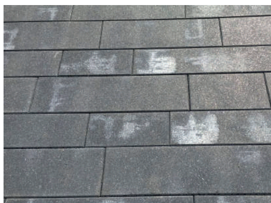
Principe de formation des efflorescences sur un pavé en béton
