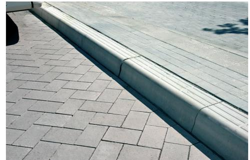
En collaboration avec le fabricant de pneumatiques Continental, nous avons développé le profil « QUAÏ DE BUS BARRIFLEX », le profil latéral permet une approche bus engendrant une friction minimale. En même temps, le profil Concave/Convexe guide le pneu en lui évitant une approche aléatoire du quai.
